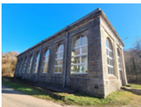
Vue extérieur du bâtiment
